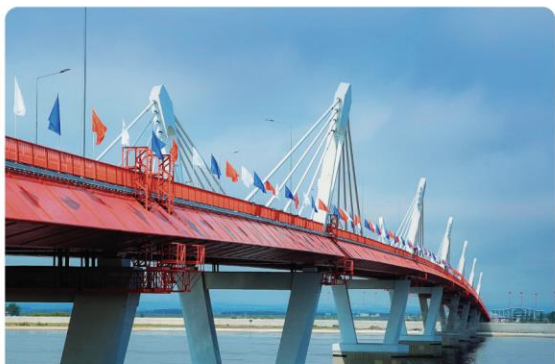
Пограничный мостовой переход через р. Амур
